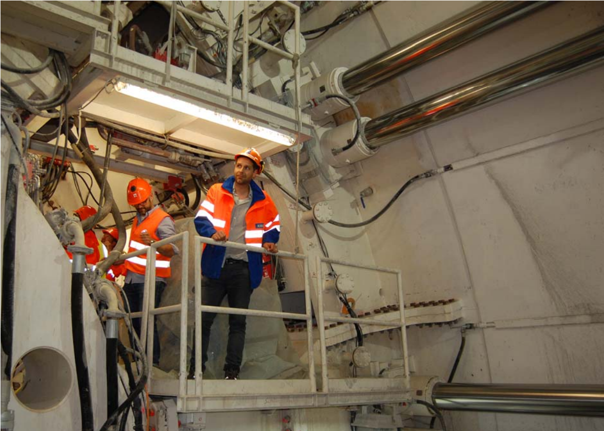
Die Grund- und Spezialtiefbauer erkunden die Tunnelbohrmaschine im Belchen und sind beeindruckt.
