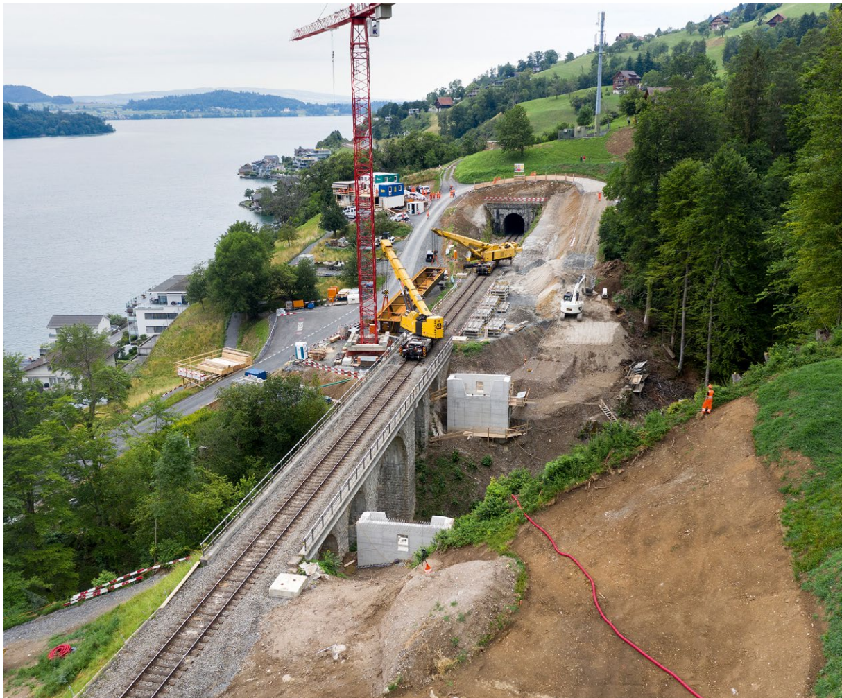
Baustellenbesichtigung «SBB Baustelle Zug – Arth-Goldau» am 24. Oktober 2019
