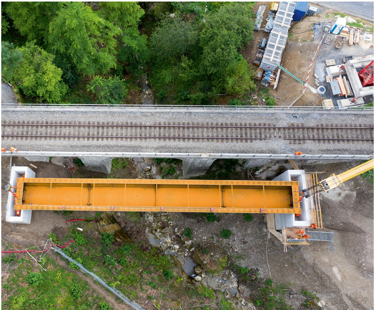
Sperre Zugersee Ost: Brückenkrane platzieren eine neue Brücke in Walchwil.
