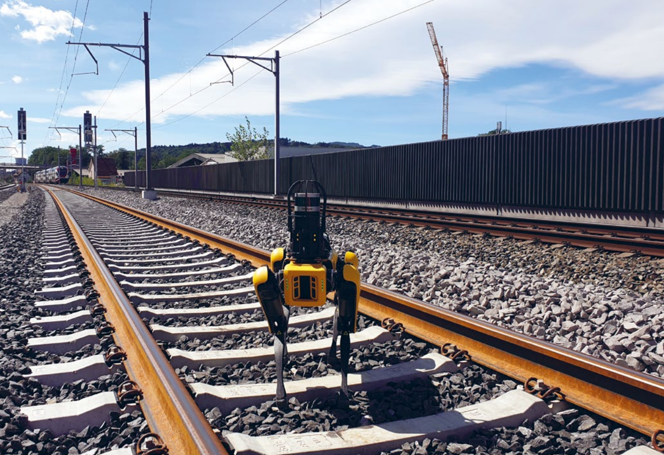
Mit seinen Kameras und Laserscannern überwacht der Roboter die Gleisarbeiten und sorgt für einen reibungslosen und sicheren Ablauf.
