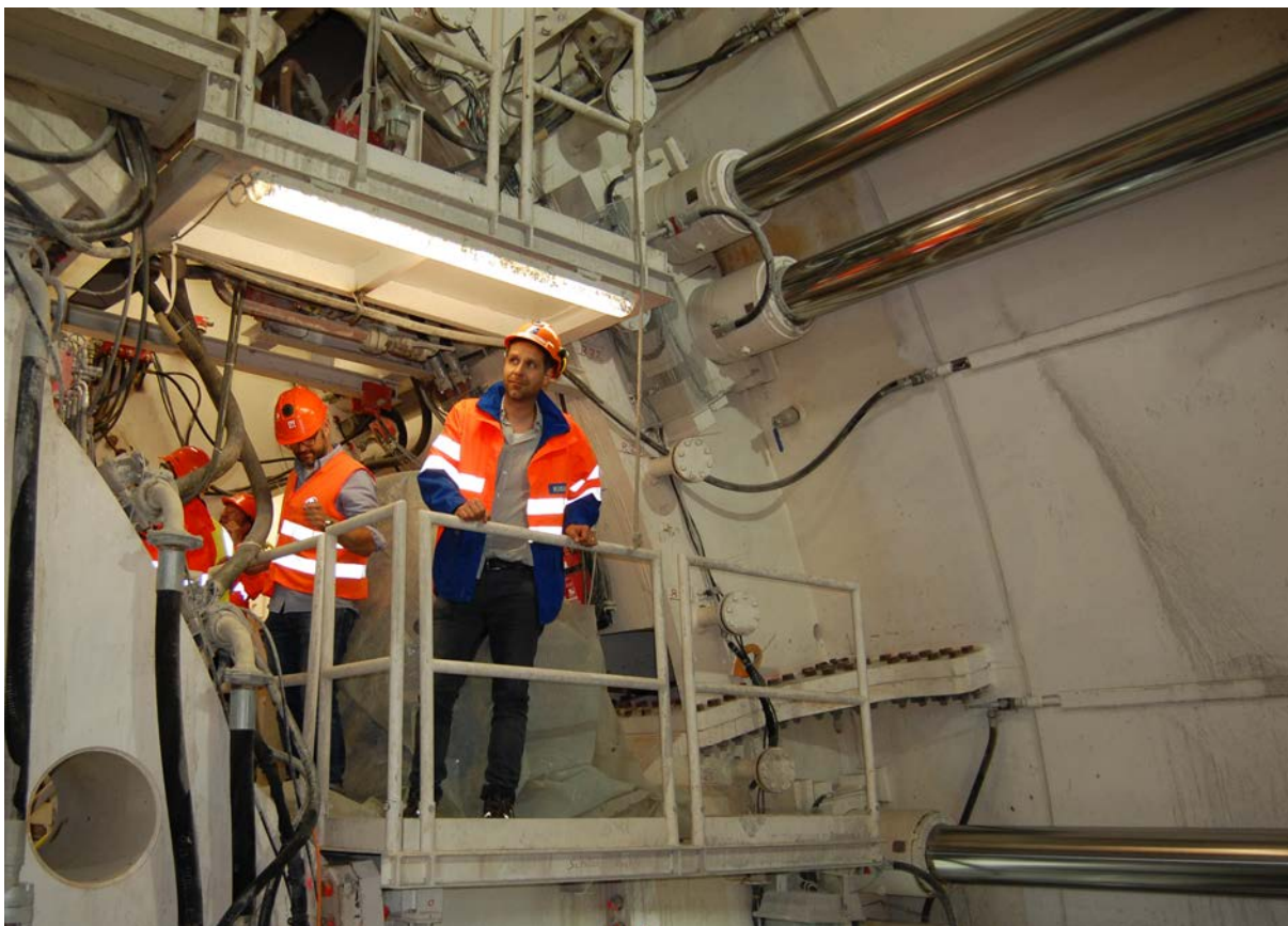
Les constructeurs de fondations et les spécialistes en génie civil admirent le tunnelier du Belchen et sont impressionnés.
