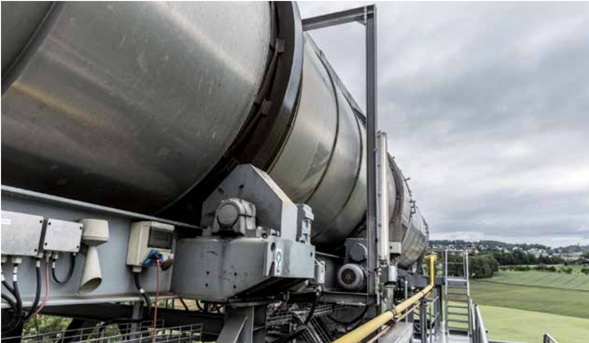
Dans les installations de Baustoff Holding Zürich AG, les matériaux recyclés sont mélangés à du sable et des gravillons neufs.
