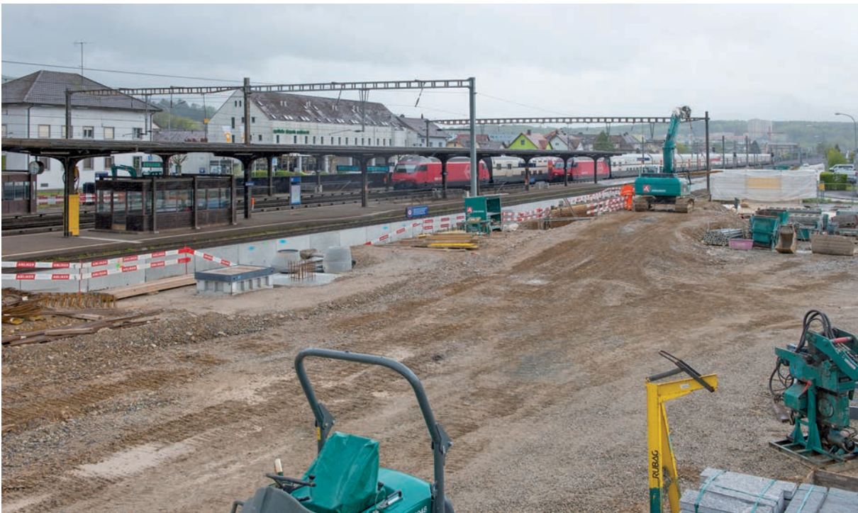
Olten-Aarau, intégrale à quatre voies (tunnel de l'Eppenberg)
