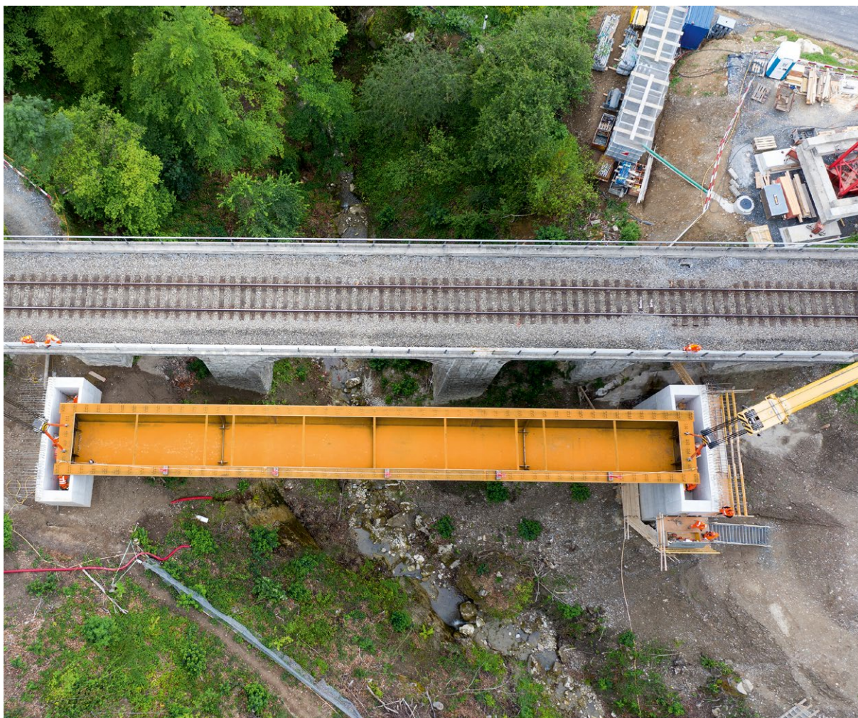
Goulet de Zugersee Ost: des grues à portique placent un nouveau pont sur le Sagenbach, à Walchwil.
