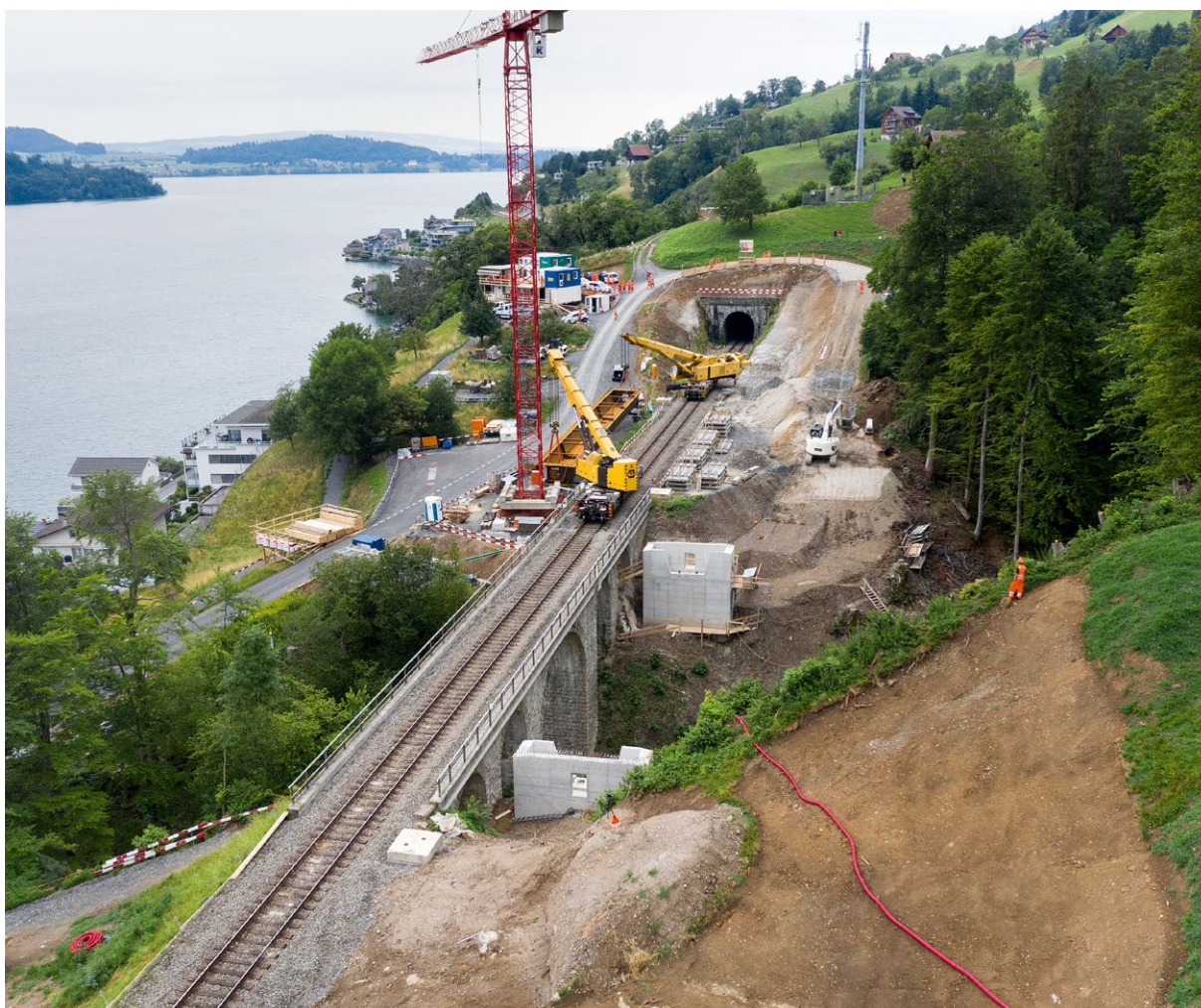
Visite du chantier CFF «Zoug – Arth-Goldau», le 24 octobre 2019
