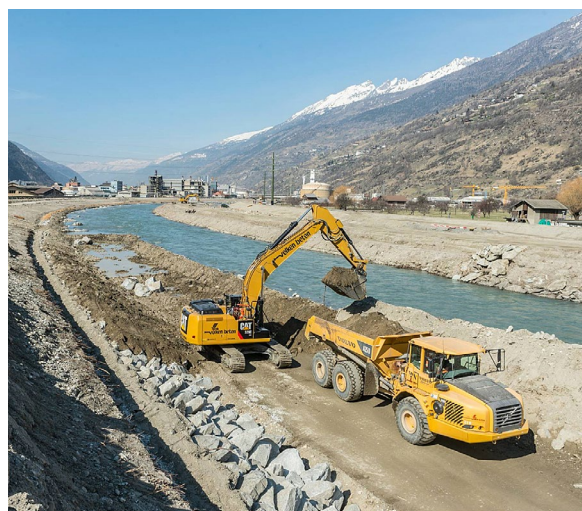
Ouvrages de protection contre les crues: travaux pour la 3ème correction du Rhône, un projet pilote du SNBS Infrastructures
