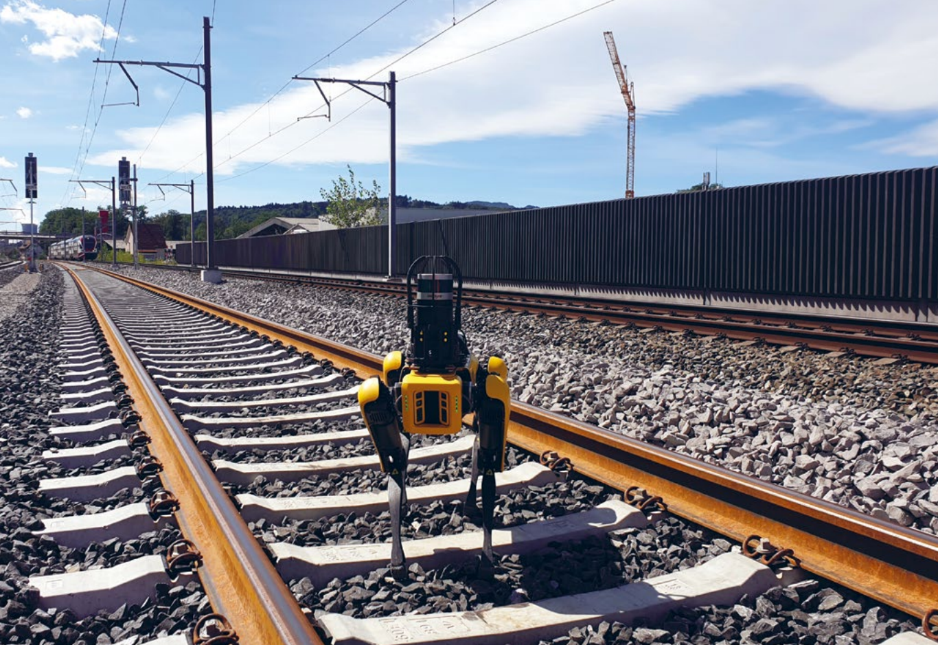
A l'aide de ses caméras et ses scanner laser, le robot surveille les travaux sur les voies et assure un déroulement sans heurts et en sécurité
