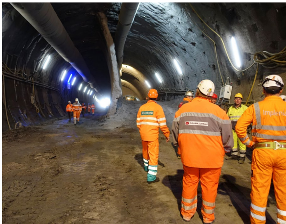
Lors de leur visite guidée de deux heures, les 18 spécialistes en travaux souterrains ont pu visiter non seulement les portails ouest et est...
