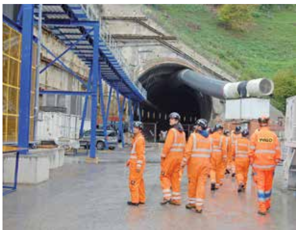
Futurs ingénieurs et ingénieurs civils en route vers le chantier du tunnel du Bözberg
