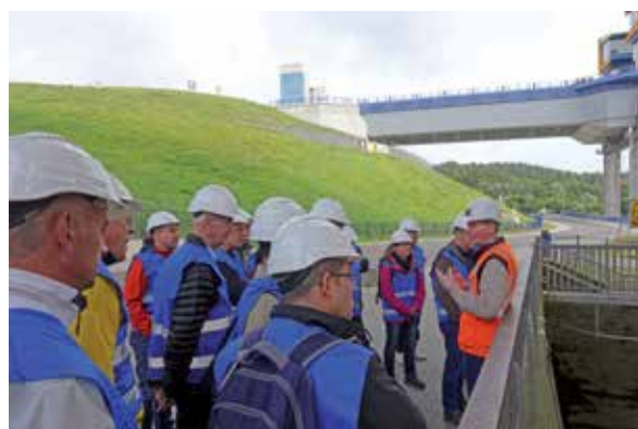
Le chantier de l'ascenseur à bateaux de Niederfinow
