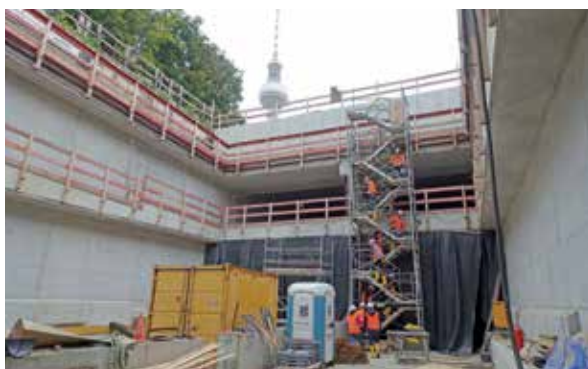
Le chantier de la ligne 5 du métro de Berlin
