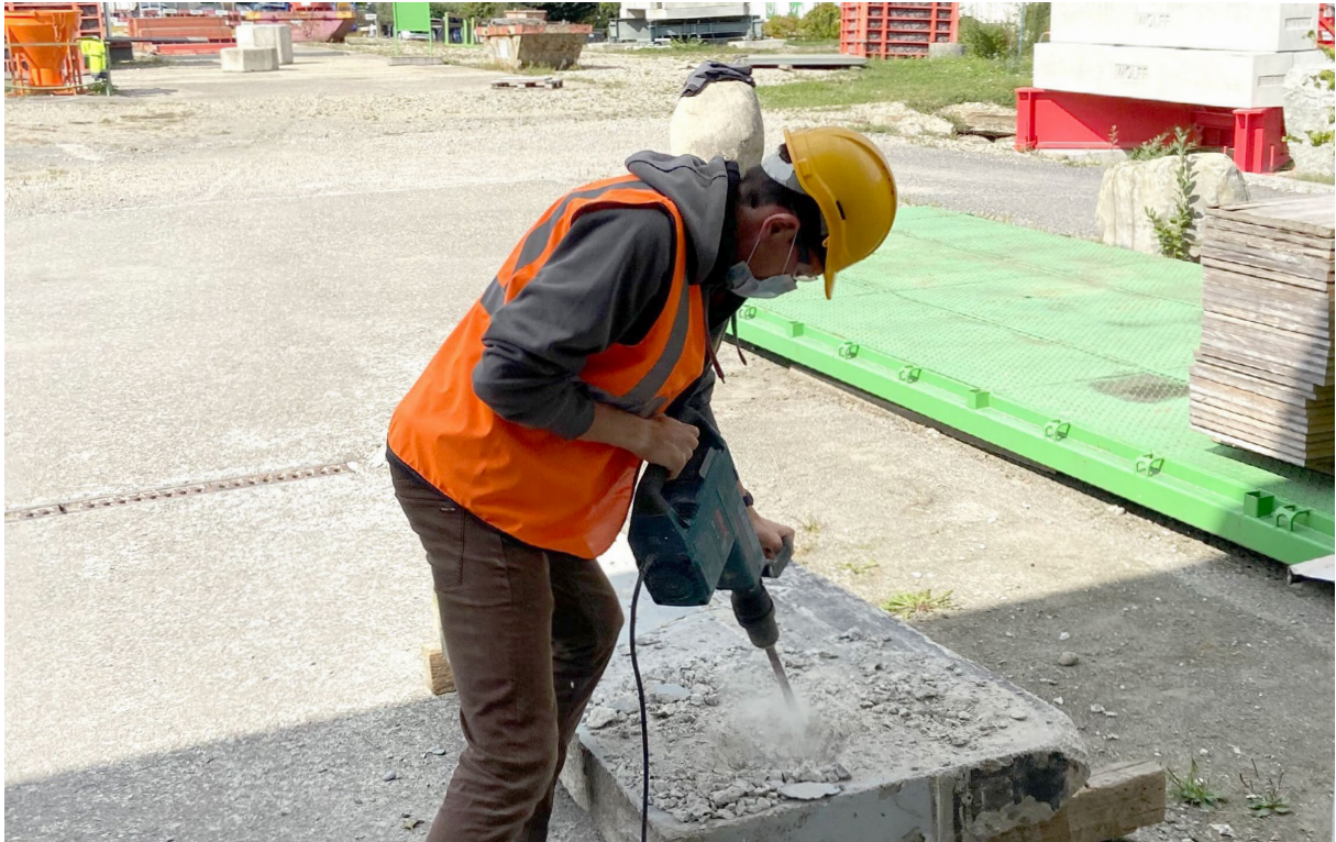
Früh übt sich, wer Tunnelbauerin oder Tunnelbauer werden will (Seite 14)
