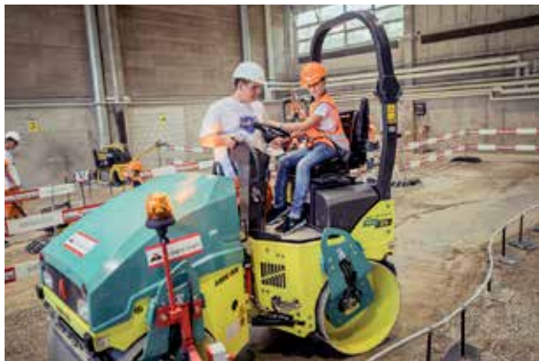
Auch das Testen von Strassenbaumaschinen stand auf dem Programm.
