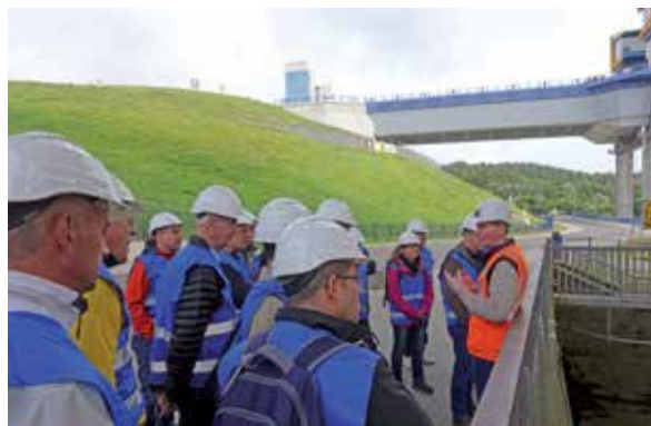
Die Baustelle des Schiffshebwerks Niederfinow
