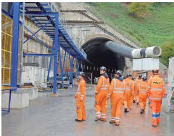
Angehende Bauingenieurinnen und Bauingenieure auf dem Weg zur Tunnelbaustelle Bözberg
