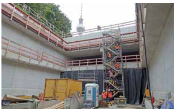
Die Baustelle der Berliner U-Bahnlinie 5
