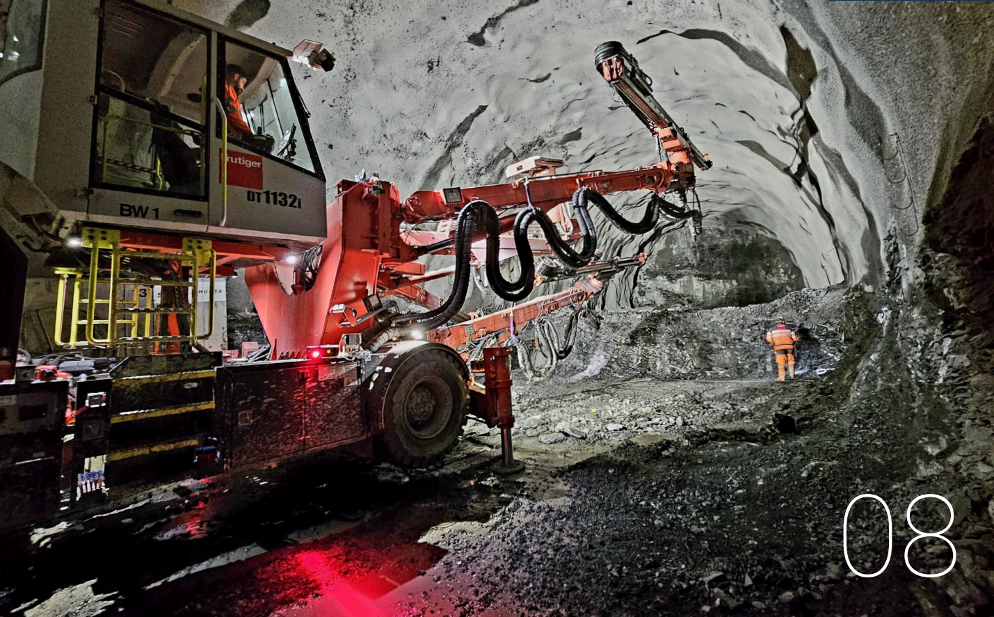
Kaiserstuhl Tunnel: Das Projekt steht exemplarisch für innovative, zukunftsorientierte Infrastrukturentwicklung, die Sicherheit, Effizienz und Umweltverträglichkeit in den Mittelpunkt stellt.
