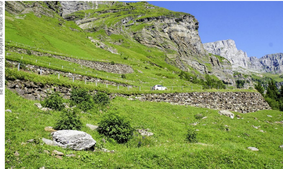
Im Kanton Uri gibt es mehrere Passstrassen, die noch historische Bausubstanz aufweisen.
